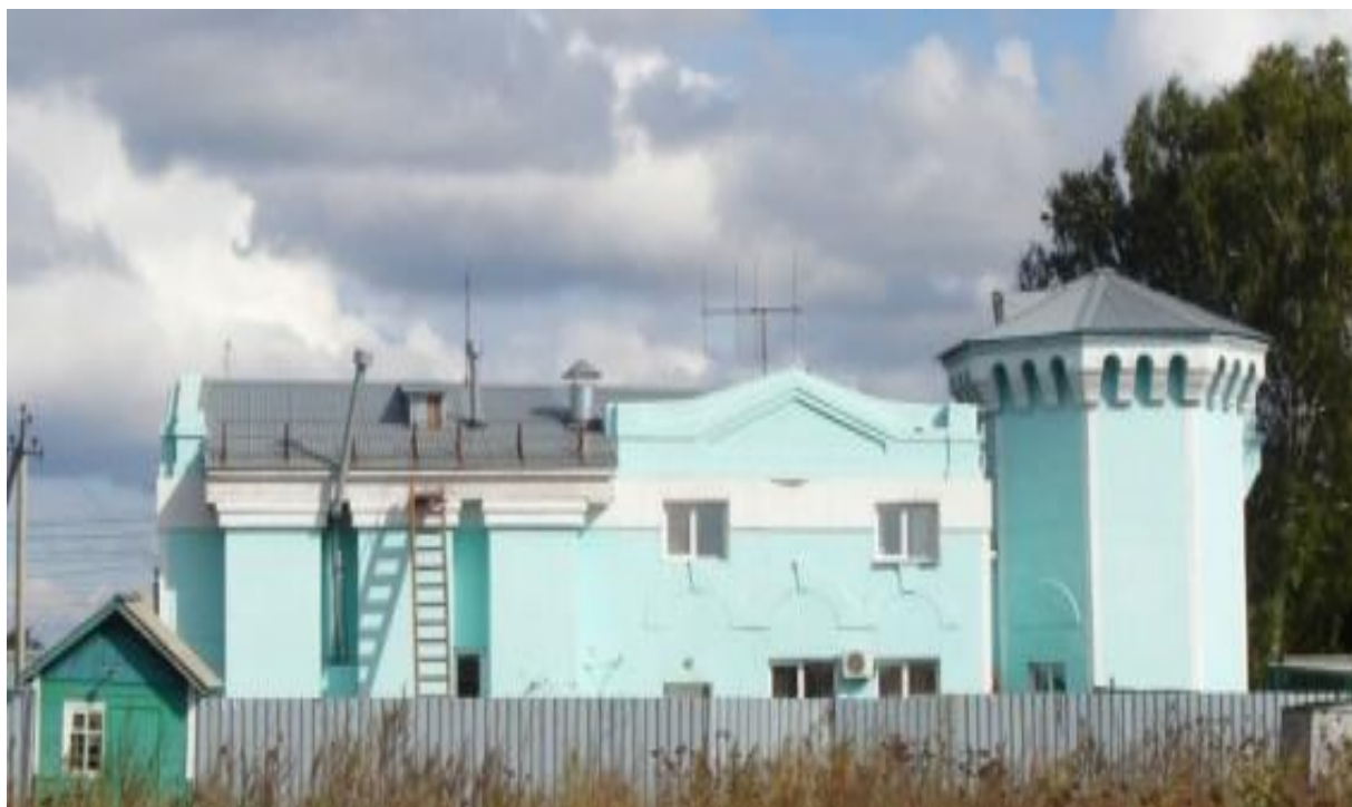
Станция насосная с водонапорной башней
